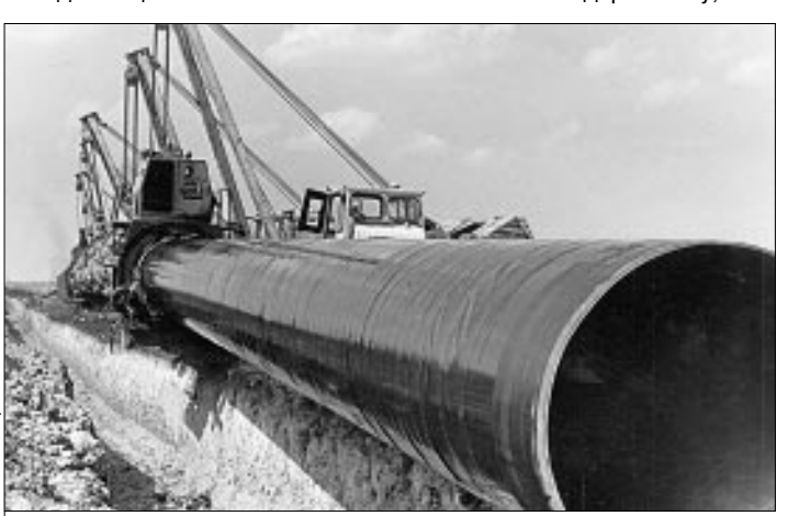
На строительстве нефтепровода Усть-Балык — Курган — Уфа — Альметьевск.
