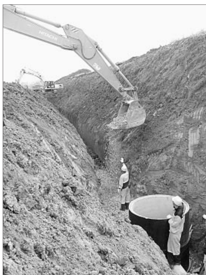
Так под ковром сооружают дренаж.
