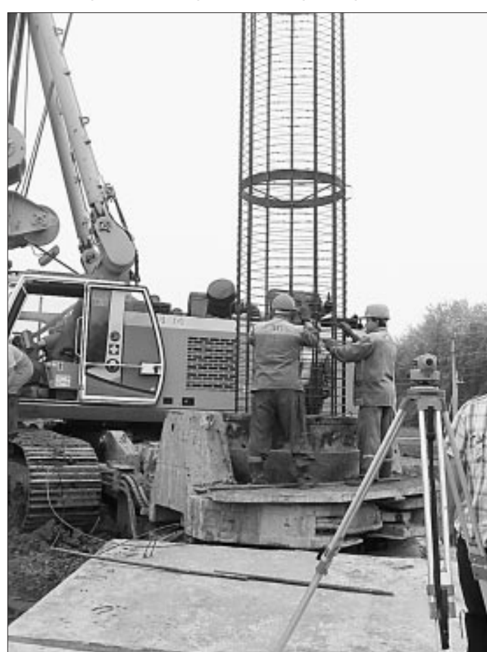
Здесь будет мост.
