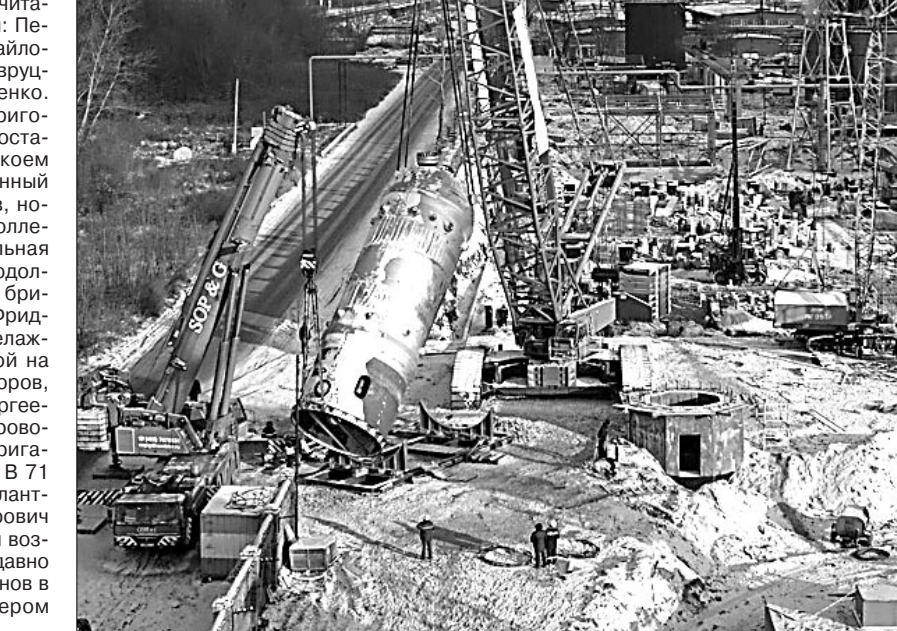
В последние дни прошлого года монтажниками УМФ № 1 произведен подъем 264-тонного реактора на ОАО «Шекиноазот».
