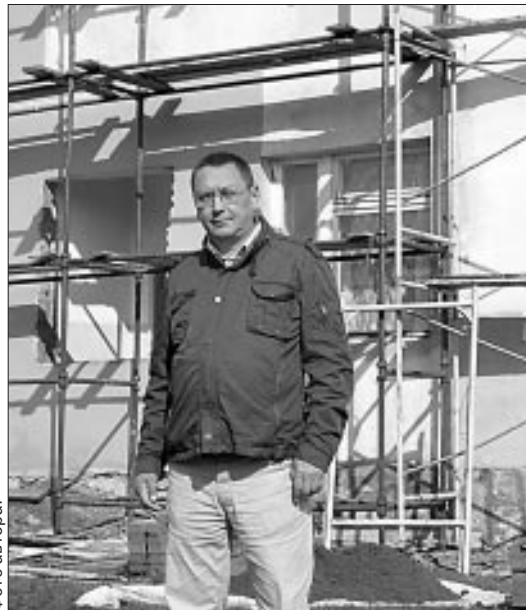
Рабочий день главного врача Мелеузовской ЦРБ Р. С. Кузубкова начинается и завершается на объектах реконструкции.
