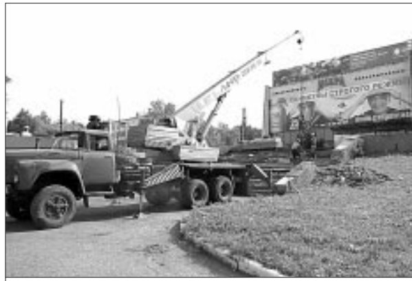
Стена нового зала пройдет по нижнему краю нынешней лестницы.
