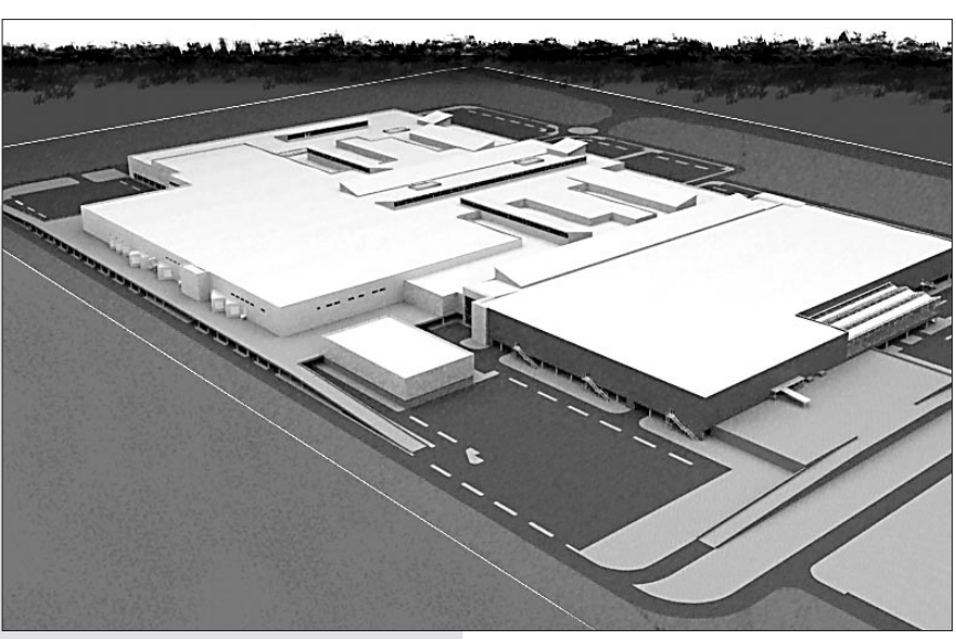
Таким будет «MEGA-IKEA» по окончании строительства.
