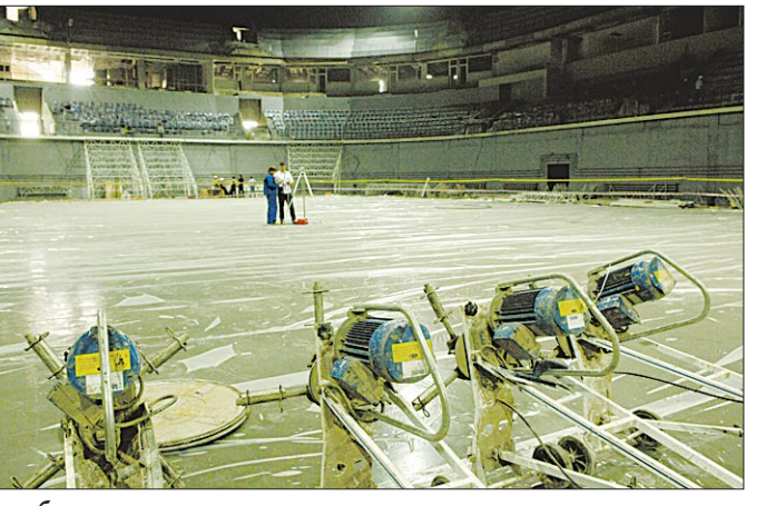
Скоро бетонное поле станет ледовым.
