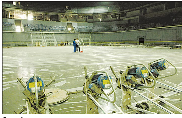
Скоро бетонное поле станет ледовым.
