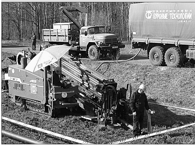
Технология направленного горизонтального бурения в действии.
